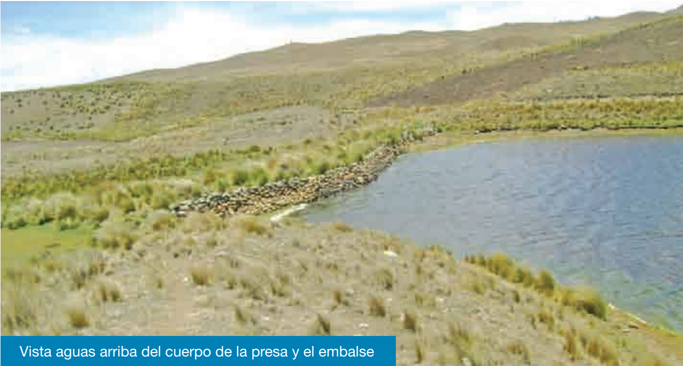
Vista aguas arriba del cuerpo de la presa y el embalse
