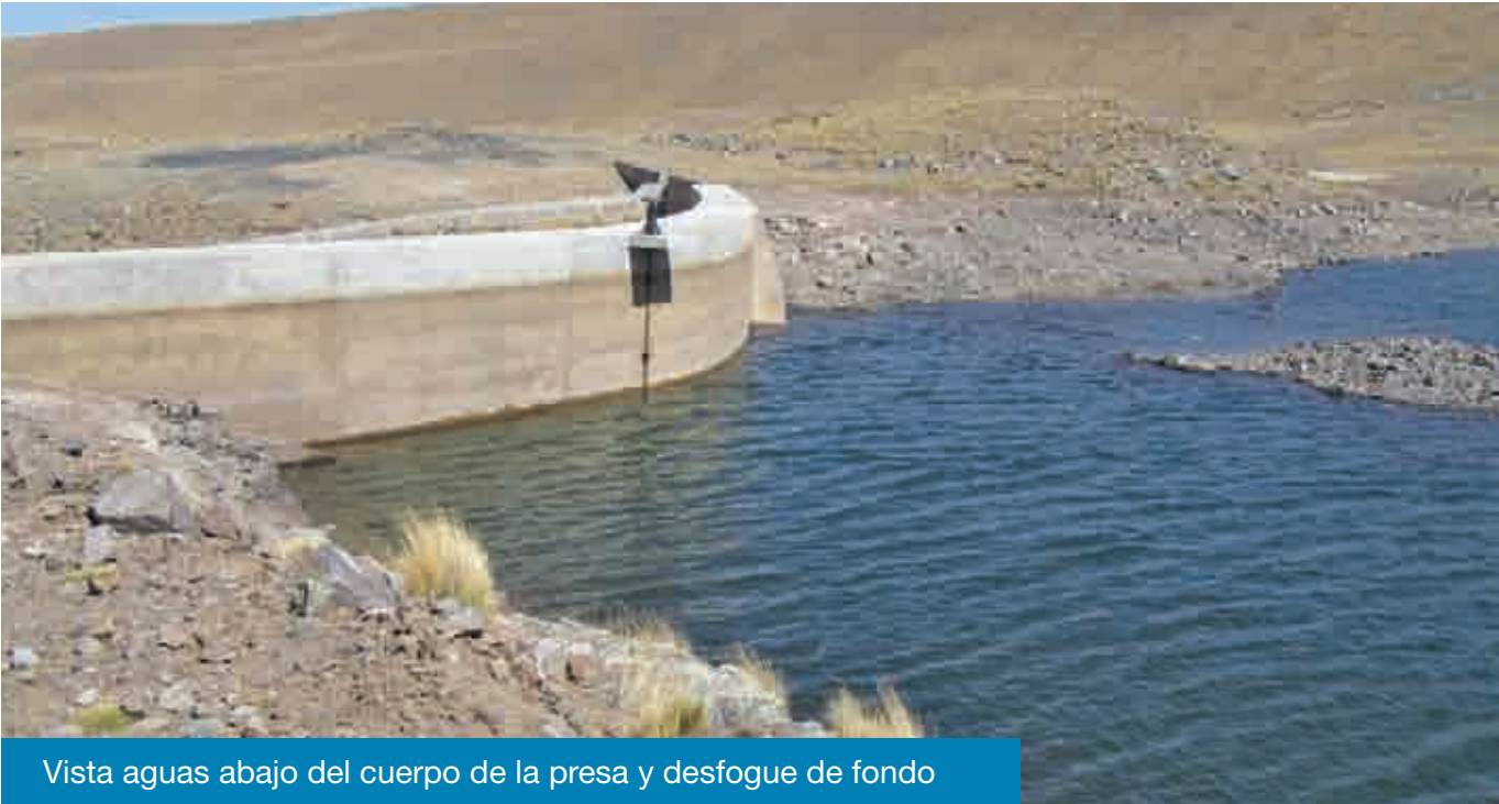
Vista aguas abajo del cuerpo de la presa y desfogue de fondo
